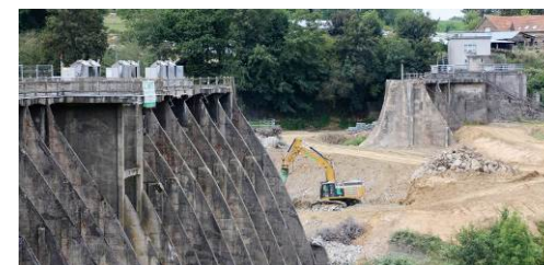
Figure 10 : Barrage de Vezins avant et pendant sa déconstruction (OFB, La Manche Libre)
