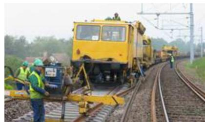
*Longs rails soudés sur traverses béton*
