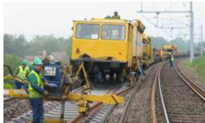
*Longs rails soudés sur traverses béton*
