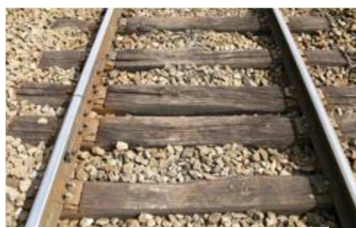
Rails courts sur traverses bois
