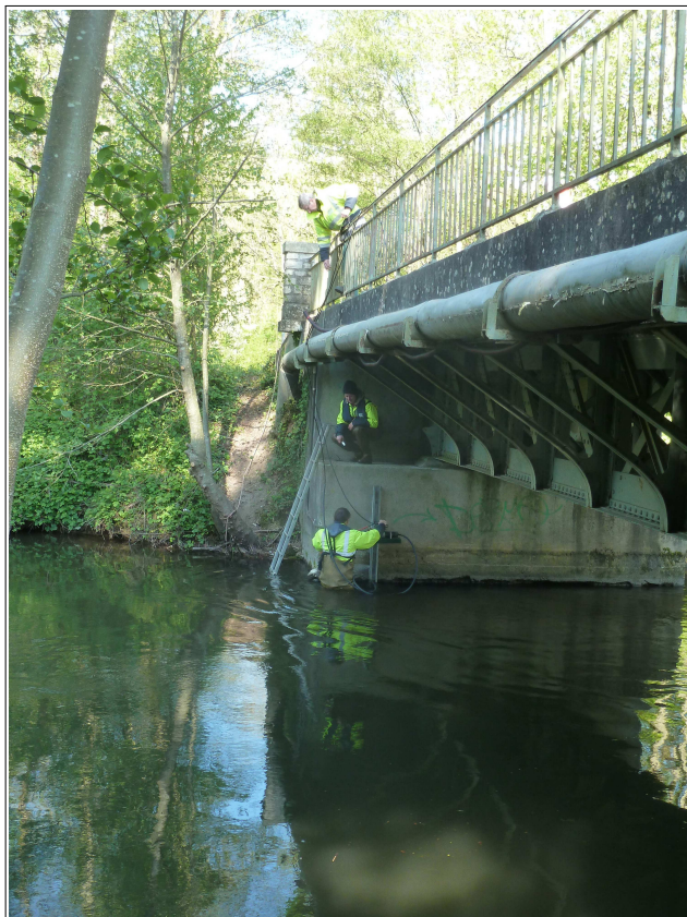
L'Essonne à Guigneville-La Mothe(91) Installation de la sonde ADCP le 26/04/2017
