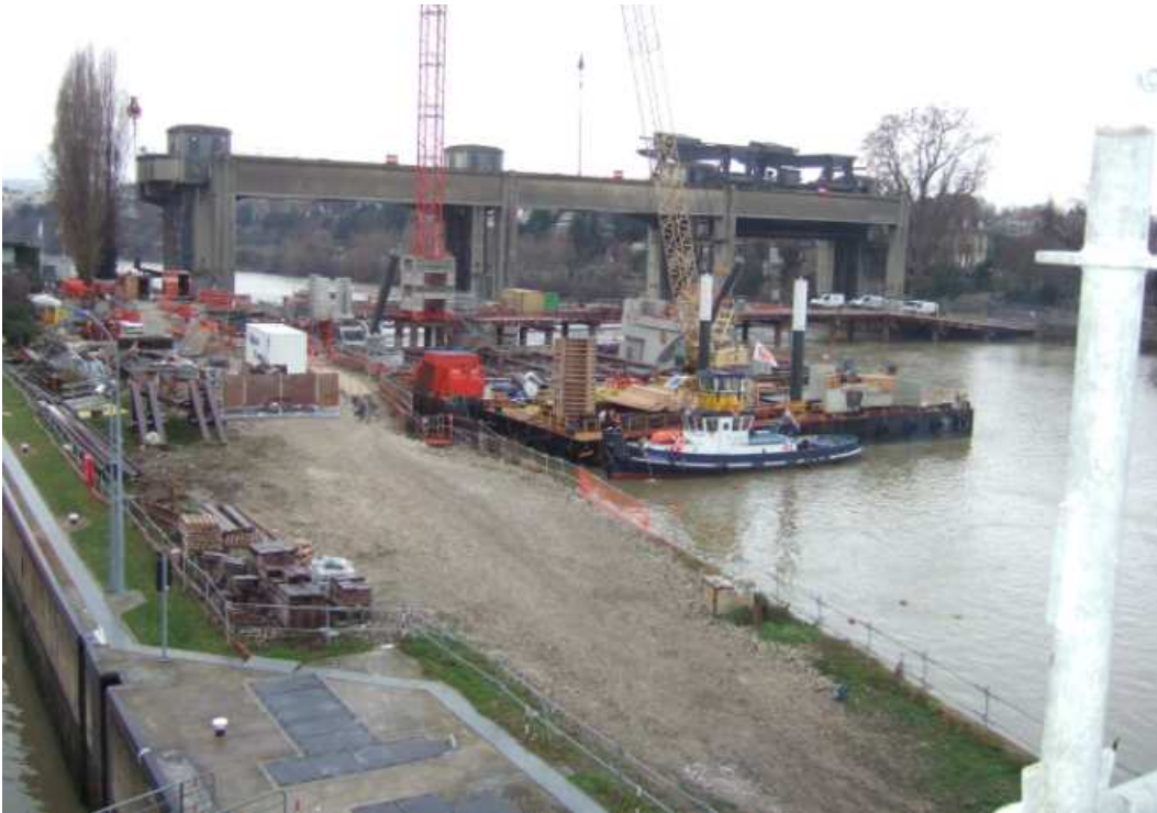
Reconstruction du barrage de Chatou (Photo DRIEE)
