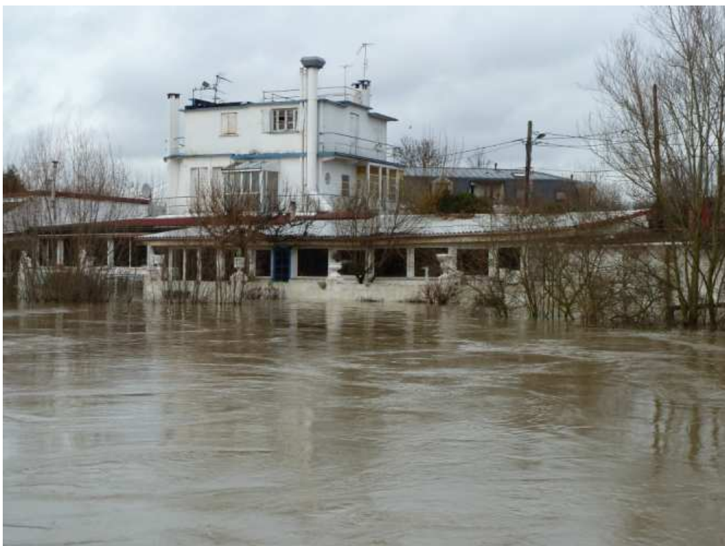
La Marne à Gournay-sur-Marne le 10 janvier 2011 (Photo DRIEE)
