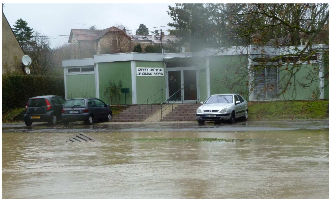
Le Grand-Morin à Couilly-Pont-aux-Dames le 7 janvier 2011 (Photo DRIEE)
