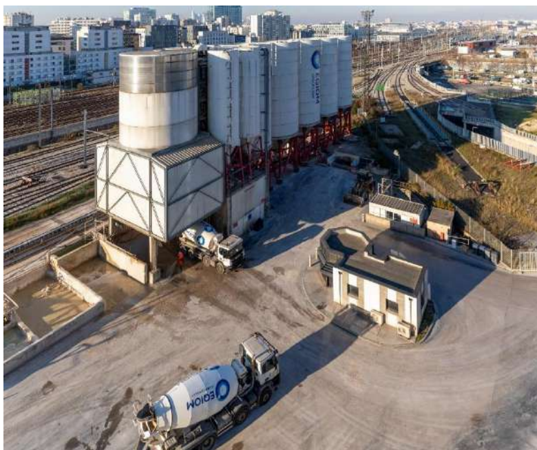
Figure 18 : Photographie d'une centrale à béton d'Île-de-France (source photo. E. Fromentin – UNICEM).
