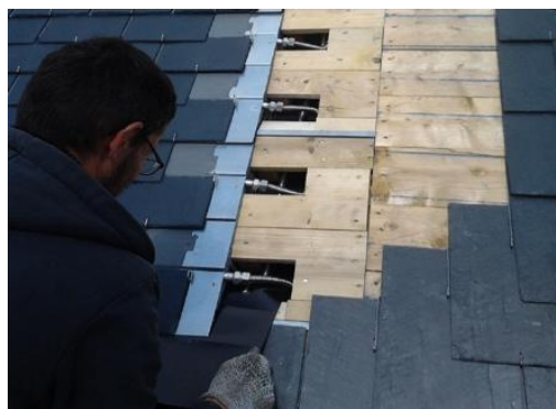
Principe de pose d'une installation solaire thermique invisible sous couverture en ardoise
