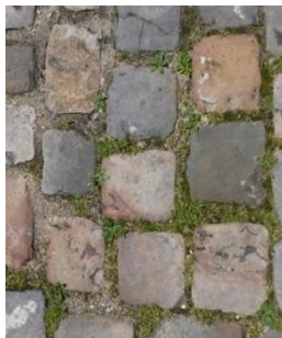
Pavé + joints de terre et chaux:
