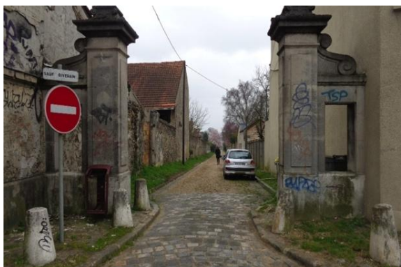
Entrée de l'allée du château et vestiges du portail d'entrée au niveau de la N20
