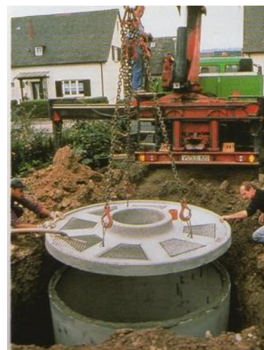
Installation d'une citerne enterrée
