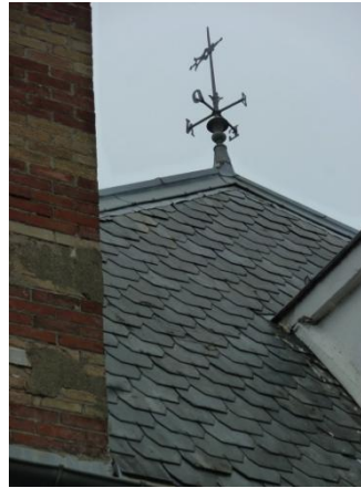
Détail de toiture à la Grange aux Cercles
