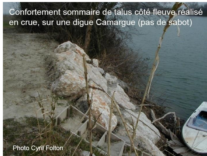
Figure 5.4 : Confortement sommaire de talus côté fleuve réalisé en crue
