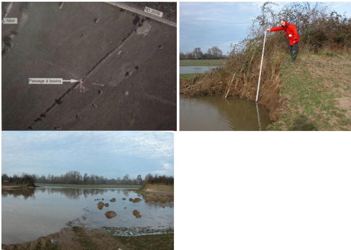
Figure 2.29 – Digue Mauboux (58) : Rupture du remblai par surverse au droit d'un passage à bovins avec un affouillement profond au niveau de la rupture – Source Cerema et DREAL Centre.
