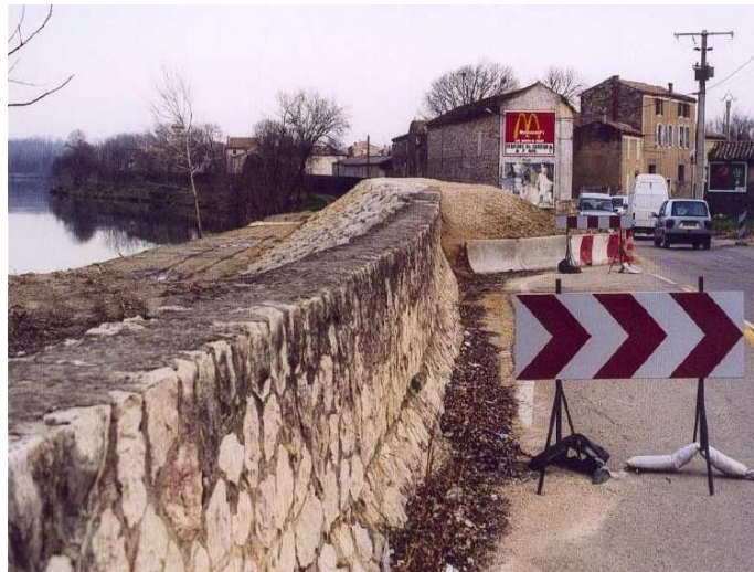
Figure 5.6 : Confortement par mise en place d'un remblai protégé par enrochements de la digue de Comps (30) suite à la crue de septembre 2002 – Photo P. Mériaux, Irstea.
