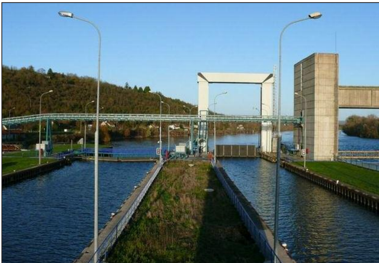
Figure 10 - L'écluse de Méricourt (Yvelines) - Source : VNF.
