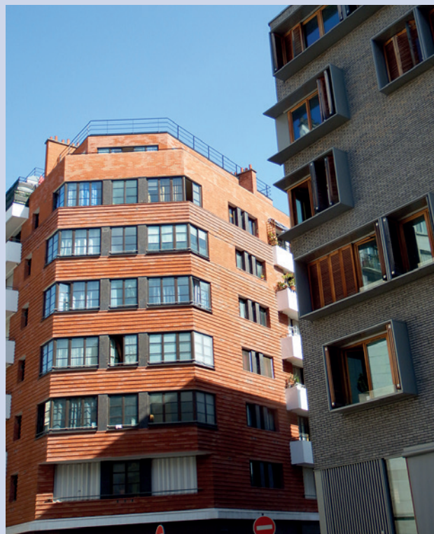
Immeubles parisiens, crédits photo :pôle RCT DRIEA 2020
