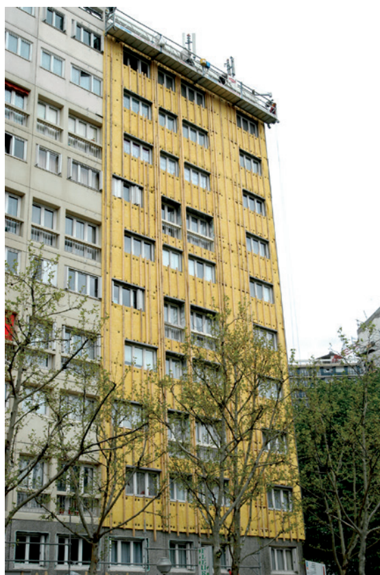
Isolation thermique par l'extérieur HLM Paris 14
