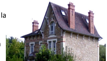
Les éléments architectoniques de la façade doivent rester visibles et authentiques.
