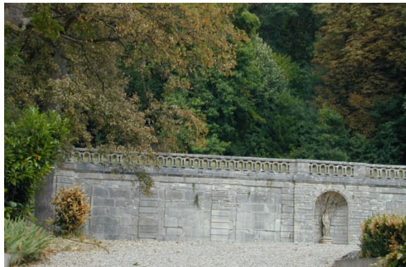
Mur de soutènement formant terrasse du château
