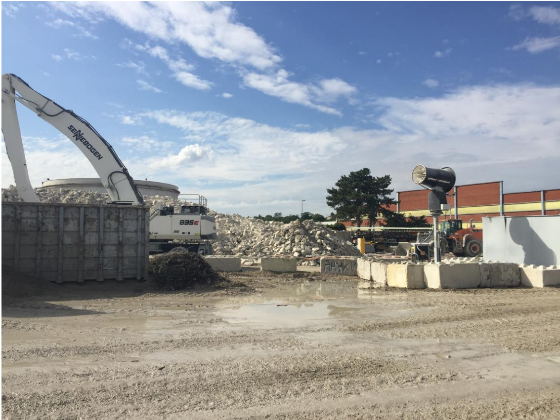
Plateforme de recyclage du BTP à Gennevilliers. Juin 2022, Source : Institut Paris Region
