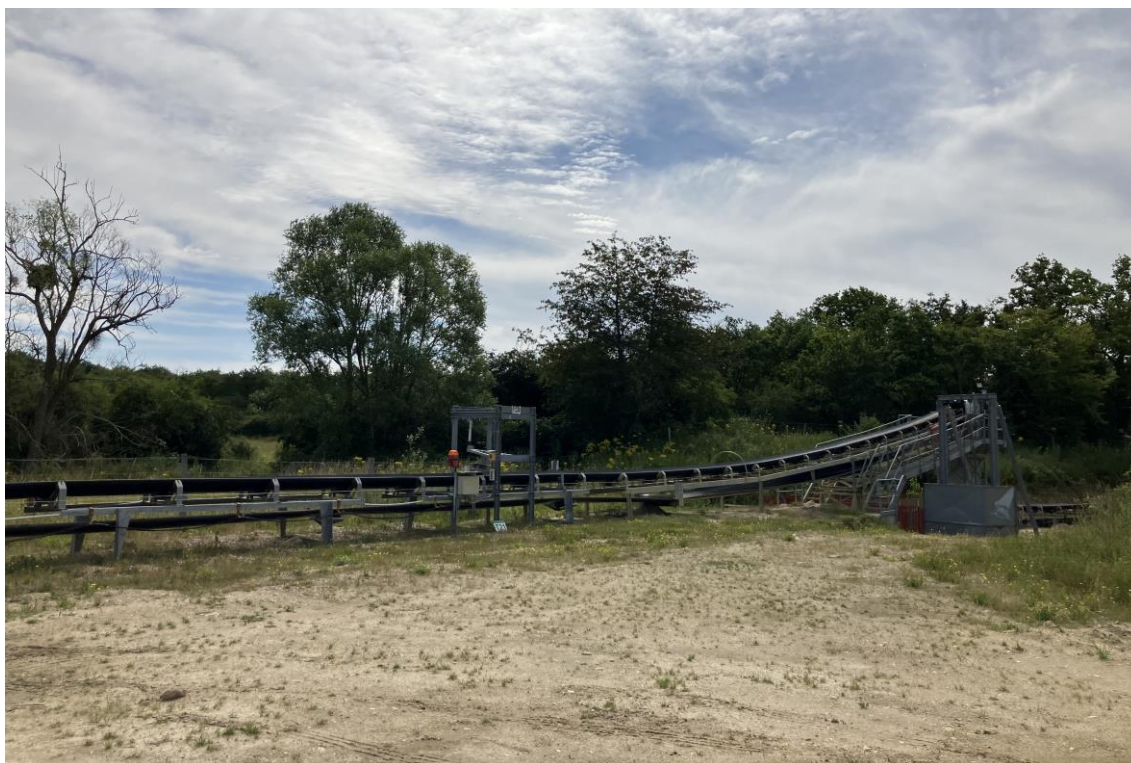
Bande convoyeuse sur une carrière dans les Yvelines. Juillet 2024, Source : Institut Paris Region.
