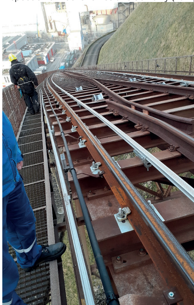
Inspection annuelle funiculaire de Penly (2024)
