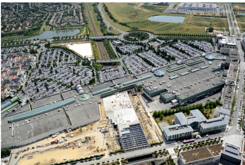
Après trois ans de travaux, le centre commercial du Val-d'Europe s'est agrandi de 17 000 mètres carrés en accueillant trente nouvelles boutiques (Le parisien.fr - 29/10/2017)
