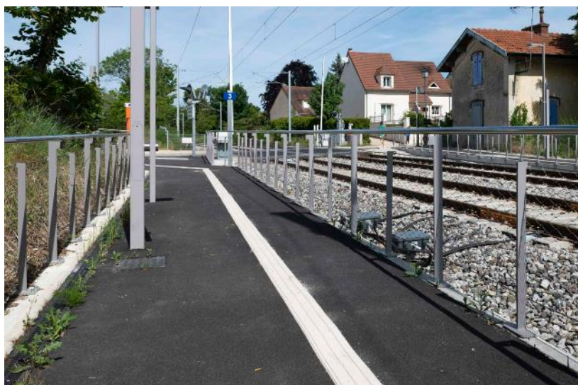
Rampe d'accès à la station Bailly © Cyril Badet
