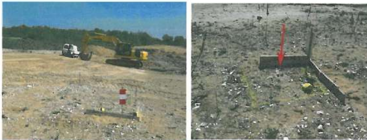
b) Repérage d'un nid avec marquage visuel avant chantier de terrassement
