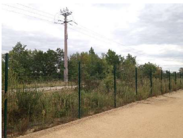
Figure 12 : Clôture installée autour du site.
