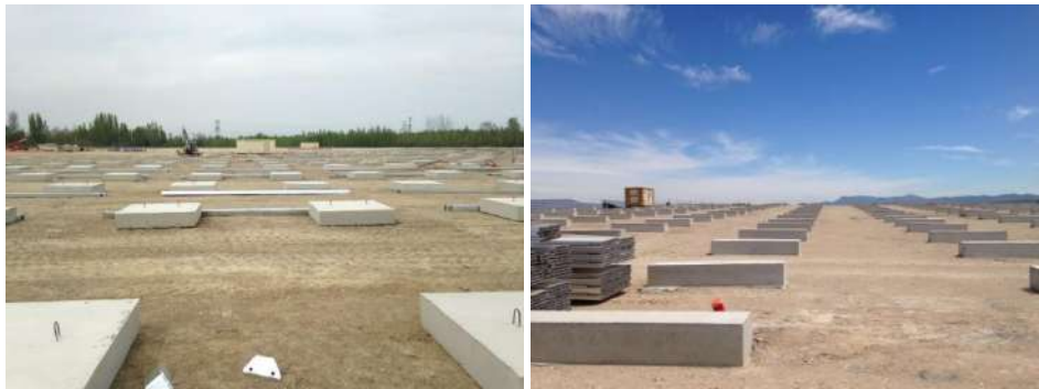
Figure 14 : Exemples d'utilisation de longrines béton sur les chantiers URBA 234 Fuveau (13) et Lavernose-Lacasse (31)
