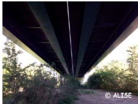
Photo 6 : Pont, sous la RD1
