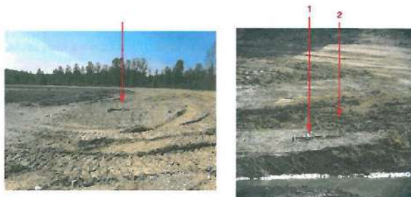
c) À gauche, début des travaux de décaissement autour du nid. À droite, après une semaine de travaux de décaissement autour du nid, un des adultes est sur le nid en train de couvrir [1] sous la surveillance du deuxième adulte [2].
