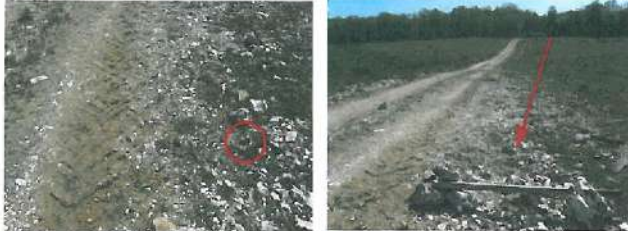
a) Repérage d'un nid à 50 cm d'un passage d'engin de chantier sur un chemin. Mise en place d'une protection simple mais efficace.
