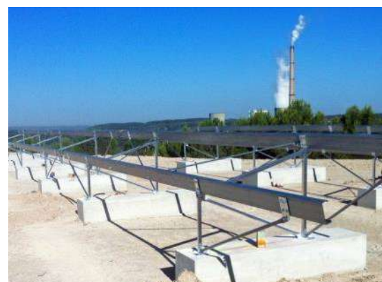
Figure 5: Structures métalliques et longrines de béton, support des tables
