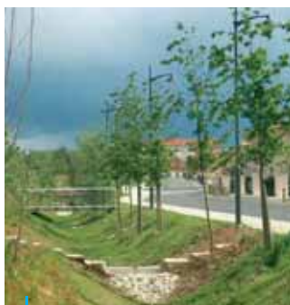
Noues cloisonnées, Parc Bouglione, Corbas
