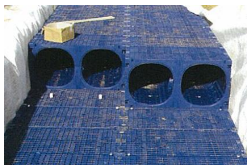
Figure 8. Exemple de stockage en structure alvéolaire et de caissons visitables
