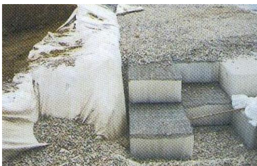
Figure 8. Exemple de stockage en structure alvéolaire et de caissons visitables
