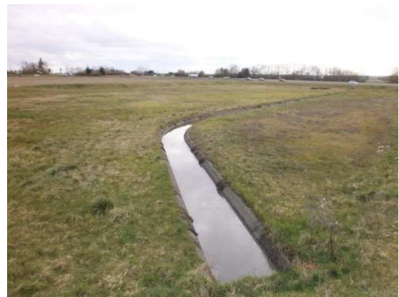
Bassin de rétention enherbé (avec étanchéité par argile compactée + caniveau béton)
