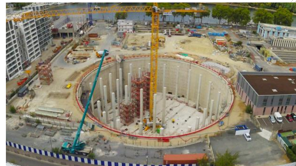
Construction d'un bassin de stockage des eaux de pluie à Clichy
