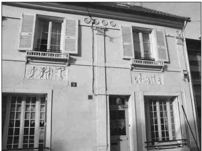
Modénature en plâtre . Détails enduits, corniches moulurées, frises, bandeaux, appuis de baies, pilastres, frontons, bas-reliefs.
