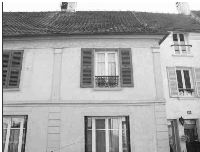
Modénature en plâtre . Détails enduits, corniches moulurées, frises, bandeaux, appuis de baies, pilastres, frontons, bas-reliefs.
