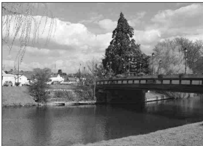
Le pont moderne. On aperçoit les vestiges de la culée de l'ancien pont, à droite de l'actuel : l'axe du pont a été modifié.
