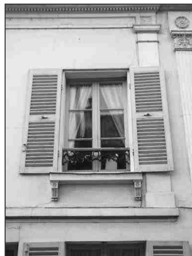
Bandeau d'étage / appui de baie isolé
