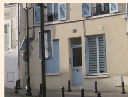
MENUISERIES : 44 rue de Paris et 23 rue de Saint-Germain : dégradation progressive des menuiseries. Le remplacement des menuiseries d'origine par des menuiseries bois entraîne dans un premier temps la disparition des petits bois. Dans un second temps, remplacement des menuiseries bois par du PVC.
