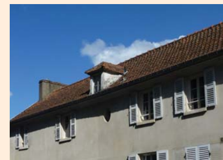
COUVERTURE : 29 rue Saint-Germain, Remplacement de la tuile plate par de la tuile mécanique
