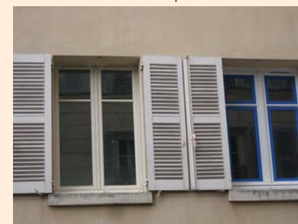
MENUISERIES : 44 rue de Paris et 23 rue de Saint-Germain : dégradation progressive des menuiseries. Le remplacement des menuiseries d'origine par des menuiseries bois entraîne dans un premier temps la disparition des petits bois. Dans un second temps, remplacement des menuiseries bois par du PVC.
