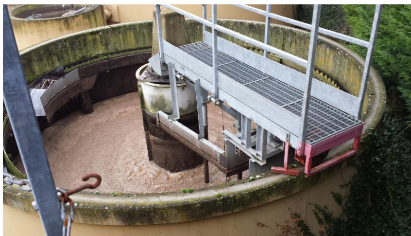
Figure 6.8 : Baisse du niveau dans le clarificateur
