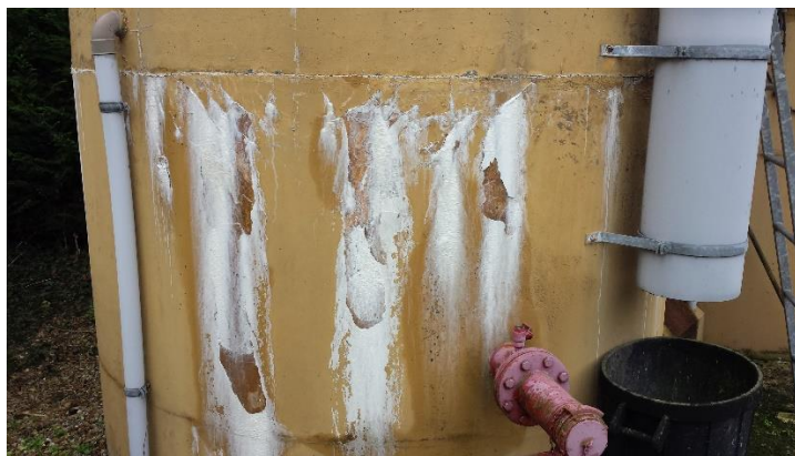
Figure 6.7 : Traces de carbonatation sur les bassins
