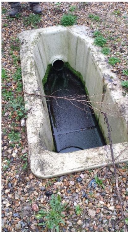
Figure 6.6 : Canal de comptage actuel en sortie de station
