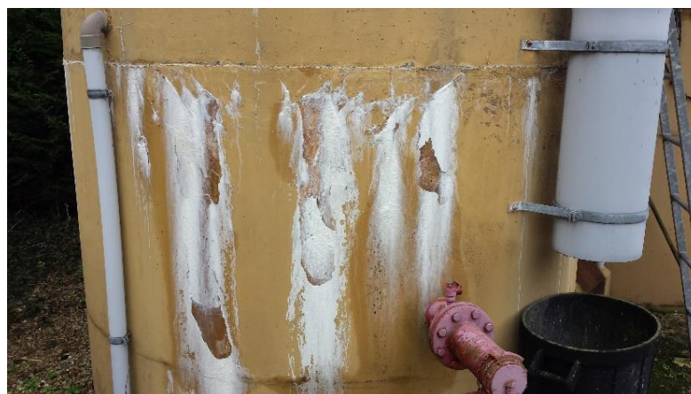
Figure 2.23 : Traces de carbonatation sur un ouvrage
