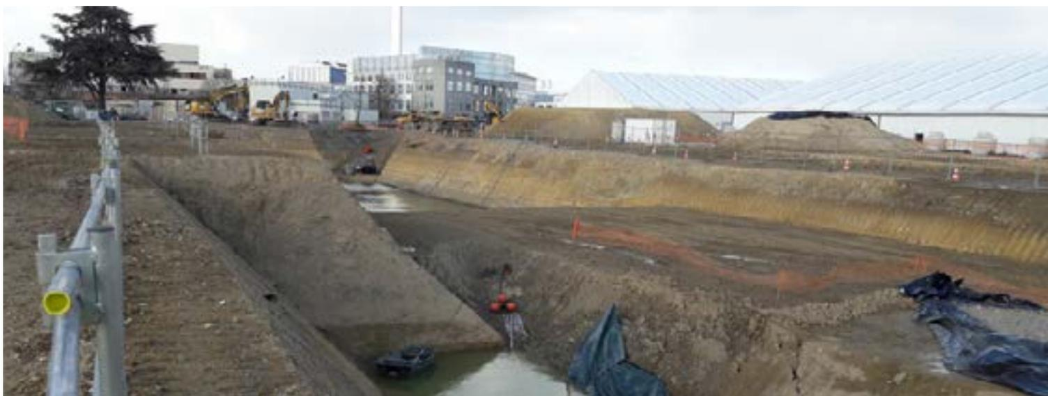
Chantier TOTAL IVRY - Fouille en cours de remblaiement, Source DRIEE
