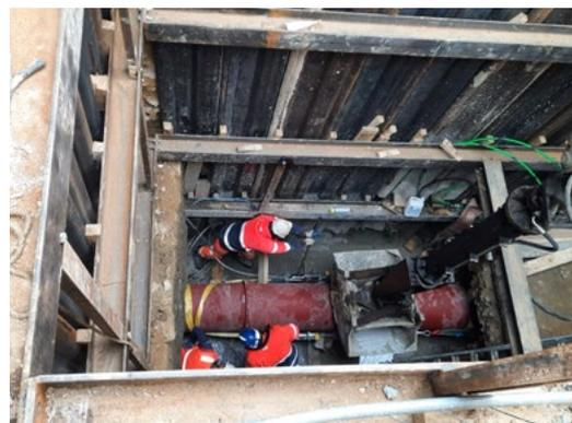
Remplacement de la canalisation de fond : elle est posée à -7 m, au niveau des fondations du barrage. Opportunité de tripler le débit de vidange de l'étang (augmentation du diamètre de la canalisation de 400 mm à 600 mm, le débit passe de 0,5 m<sup>3</sup>/s à 1,5 m<sup>3</sup>/s).
