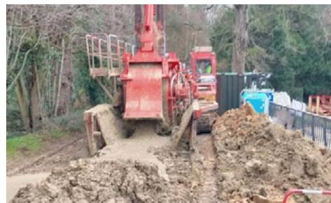
Réalisation d'un écran étanche dans le corps du barrage : méthode du Trenchmix, traitement du sol en place par liant hydraulique.
