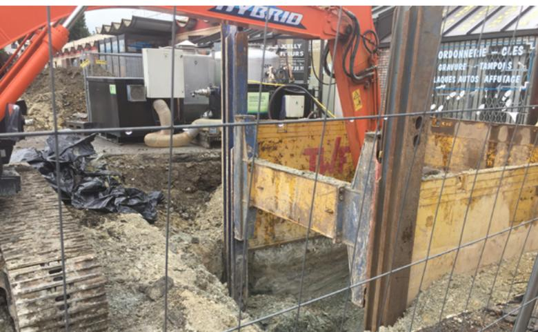
Excavation nécessaire à la mise en place de la tranchée drainante (blindages permettant de maintenir la stabilité de la fouille), source : DRIEE
