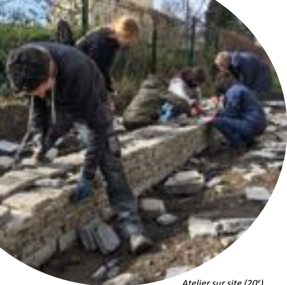
Atelier sur site (20 e )
